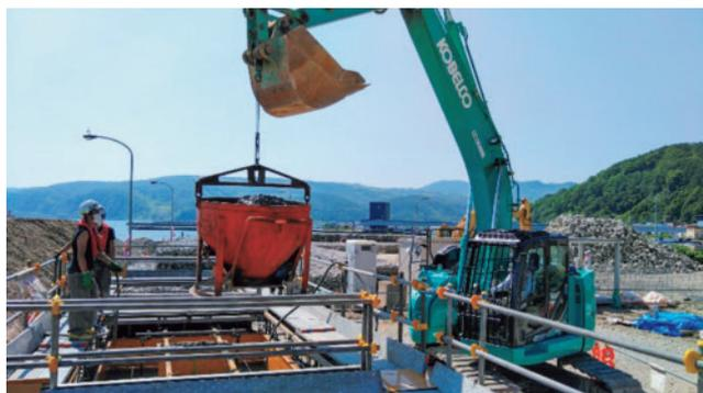
根固方塊のコンクリート打設作業
