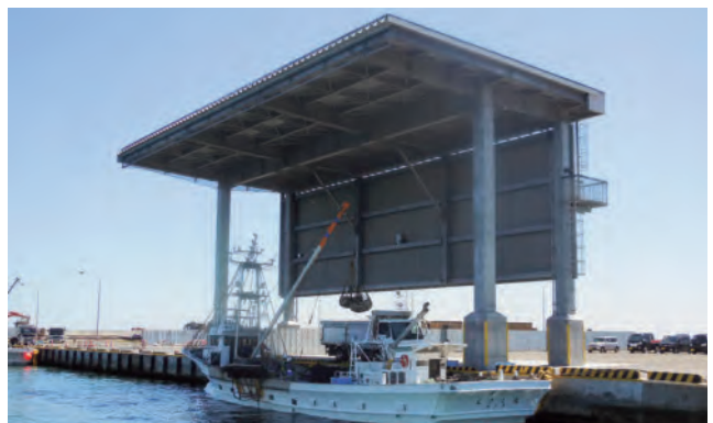
完成した屋根施設
