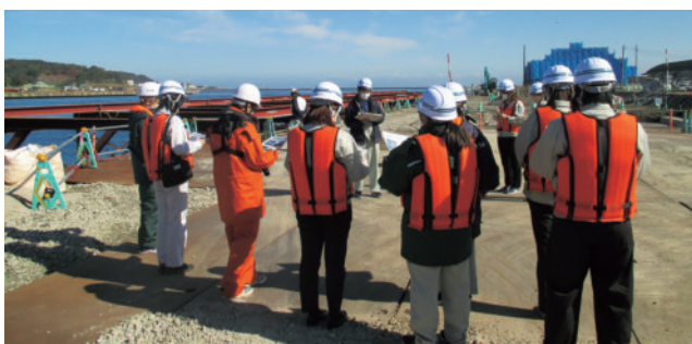
-10m岸壁工事現場視察の様子
