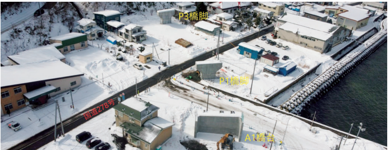
写真4 橋脚の施工状況写真
