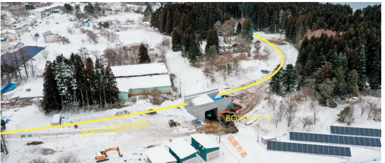
写真5 BOXカルバートの施工状況
