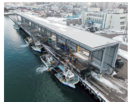
供用を開始した屋根付き岸壁
