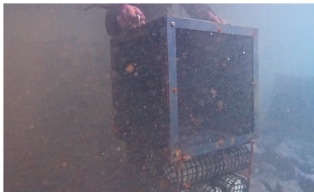
写真-2 防護ネットの装着
