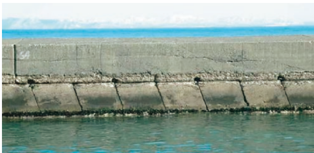
写真-4 傾斜積ブロック
