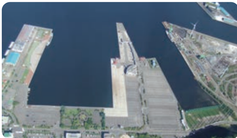
耐震岸壁全景
