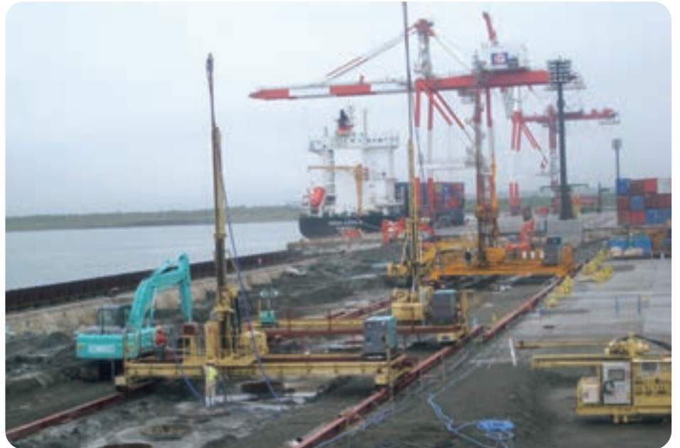
供用しながらの地盤改良（高圧噴射）
