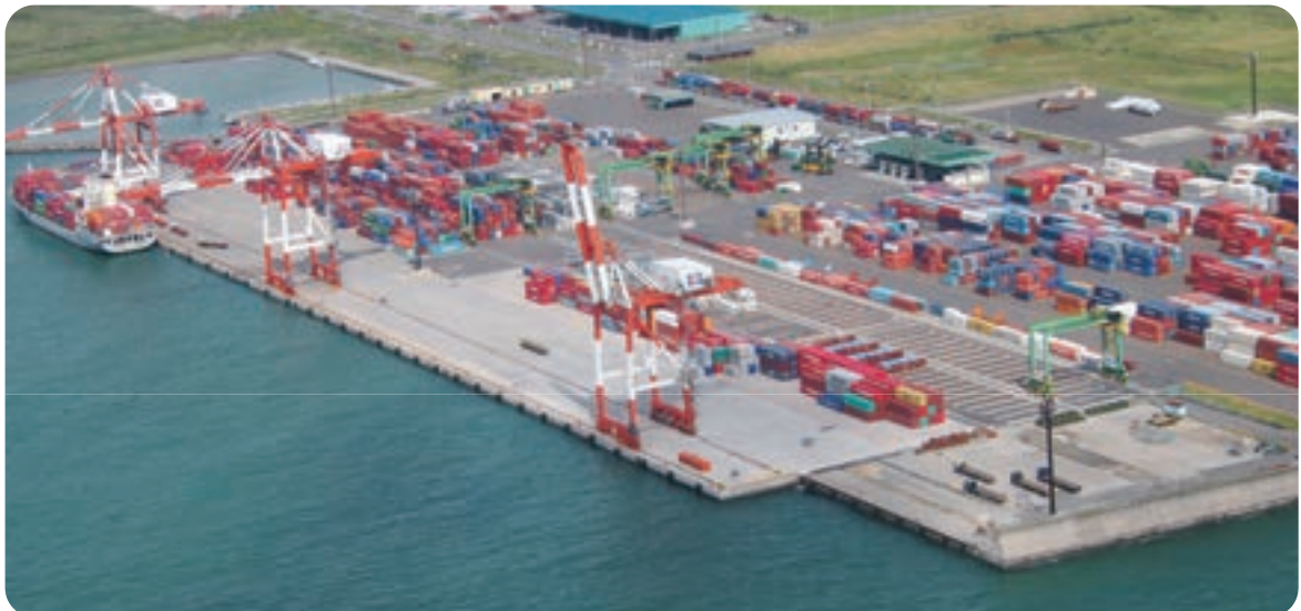
完成（平成 24 年 1 月供用）
