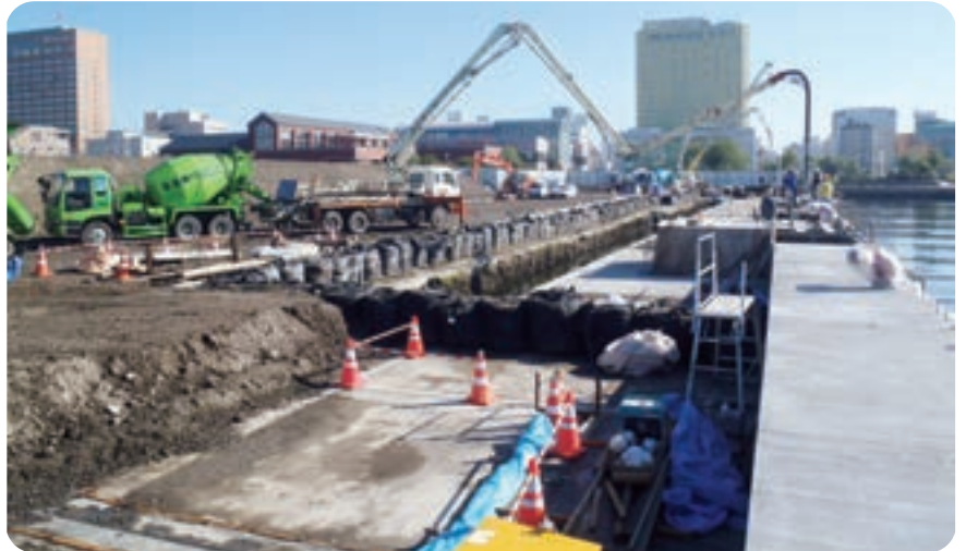
耐震岸壁上部コンクリート打設
