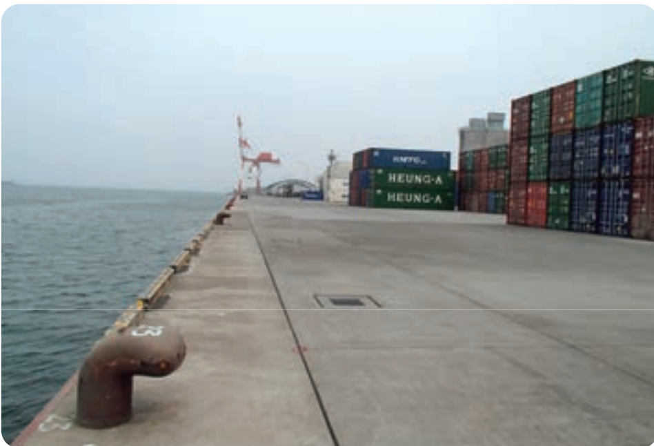
完成 (平成 25 年 5 月)
