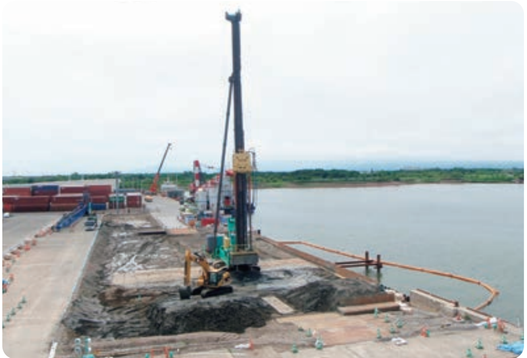
深層混合処理工法 (SDM-Dy) による地盤改良
