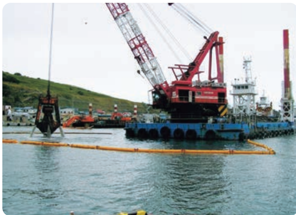
水深 5.0 m 泊地浚渫
