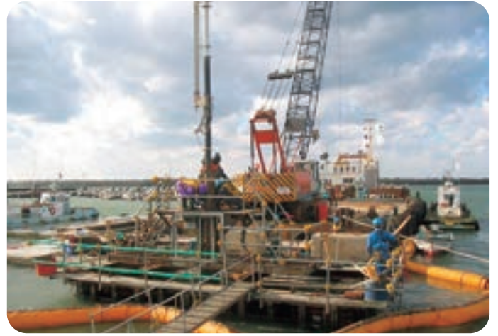
本體工 水中コンクリート打設
