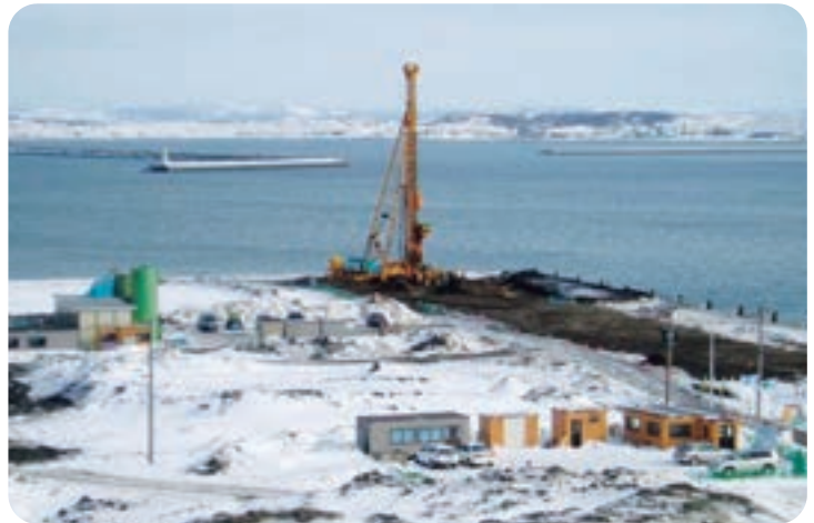
サンドコンパクション工法による地盤改良
