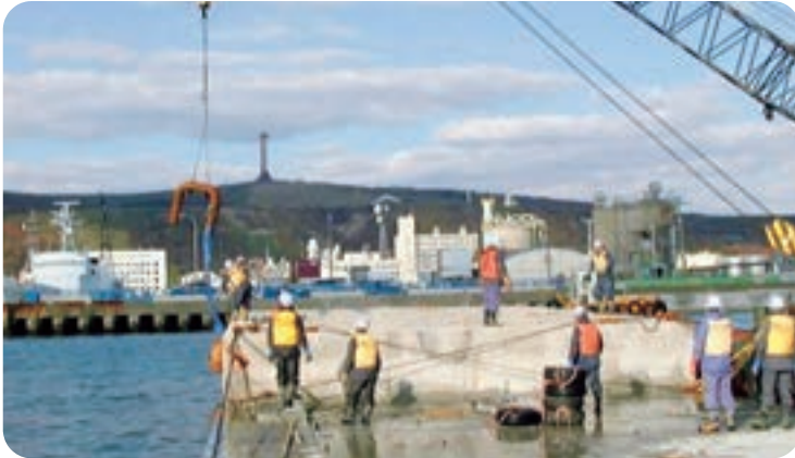
ケーソン据付
