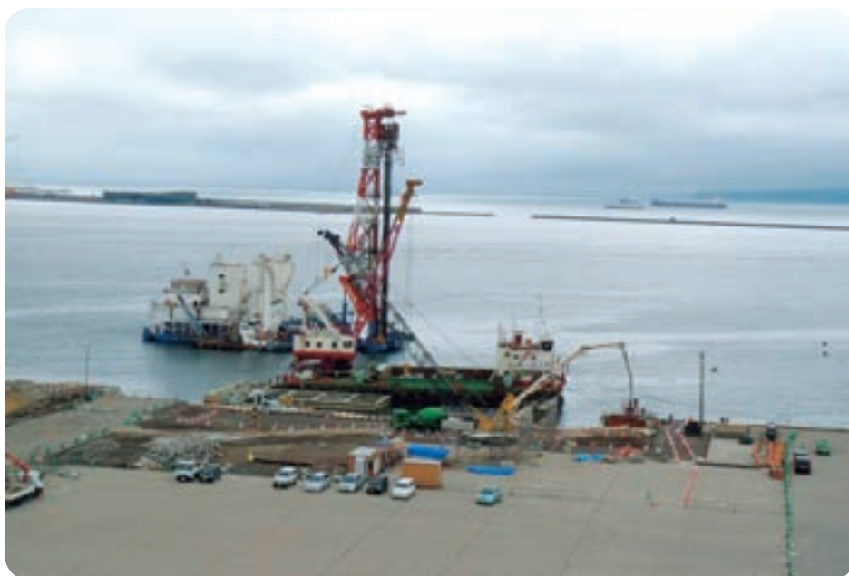
深層混合処理工法による地盤改良
