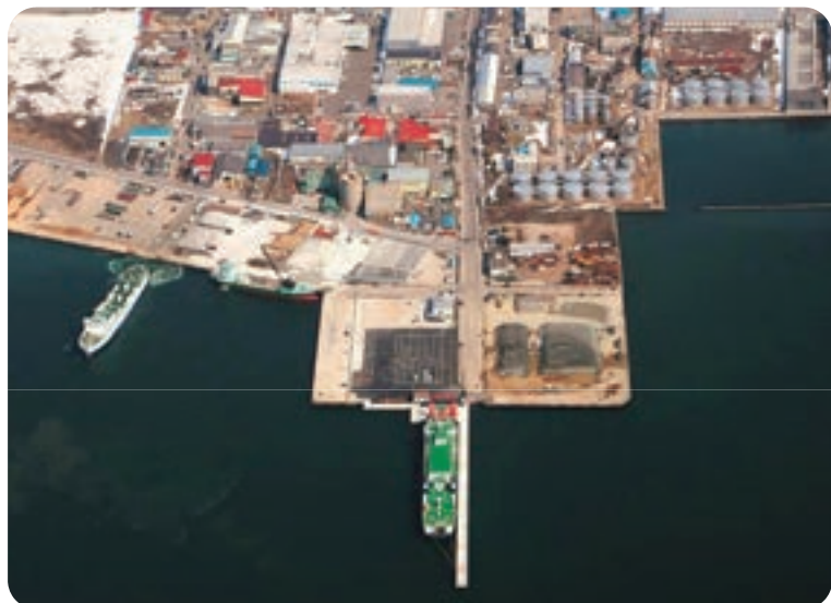
完成(平成 26 年 3 月暫定供用)
