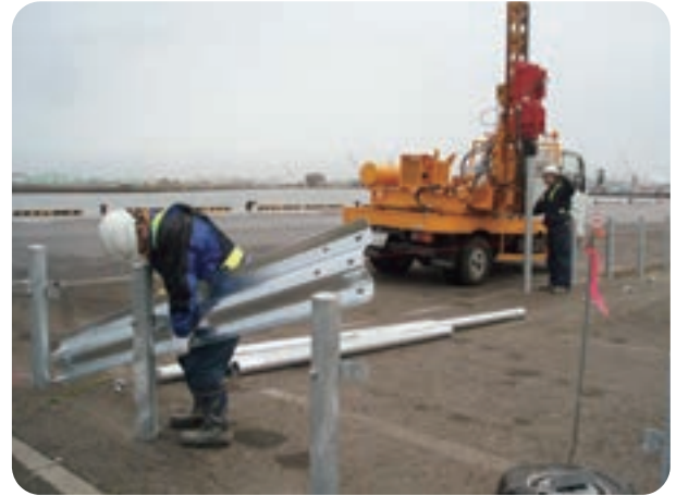
[施工中] 本體工 (支柱建込)
