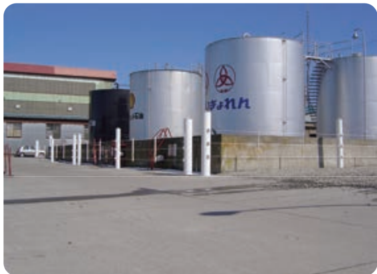
【完成・タンク廻り】
