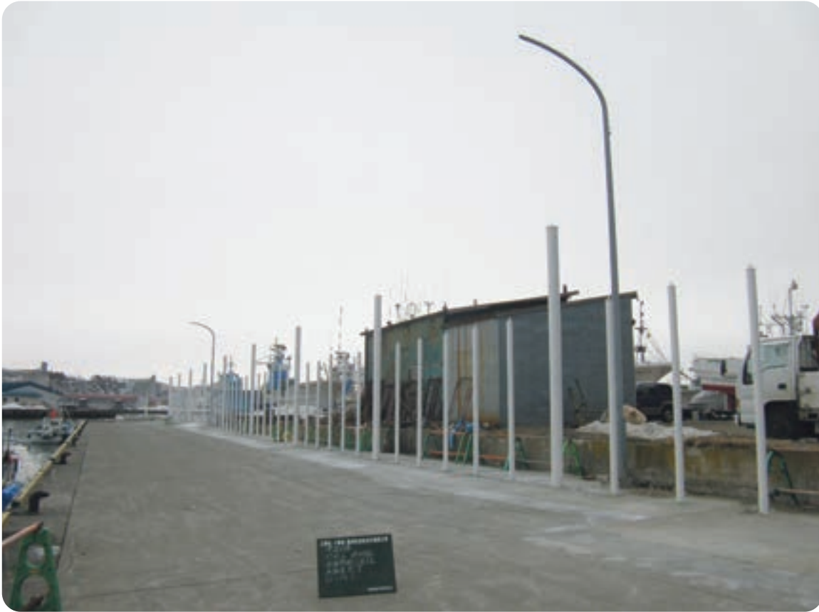
【完成・船揚場側】
