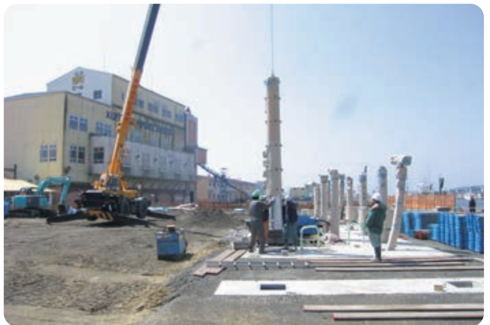
[施工中] 本體工 (支柱建込)
