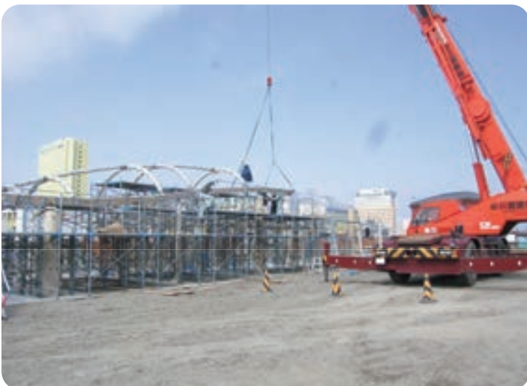
[施工中] 本體工 (天幕鉄骨)
