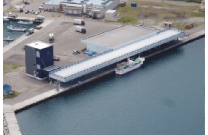
−4.0 m 岸壁(衛生管理型)全景
