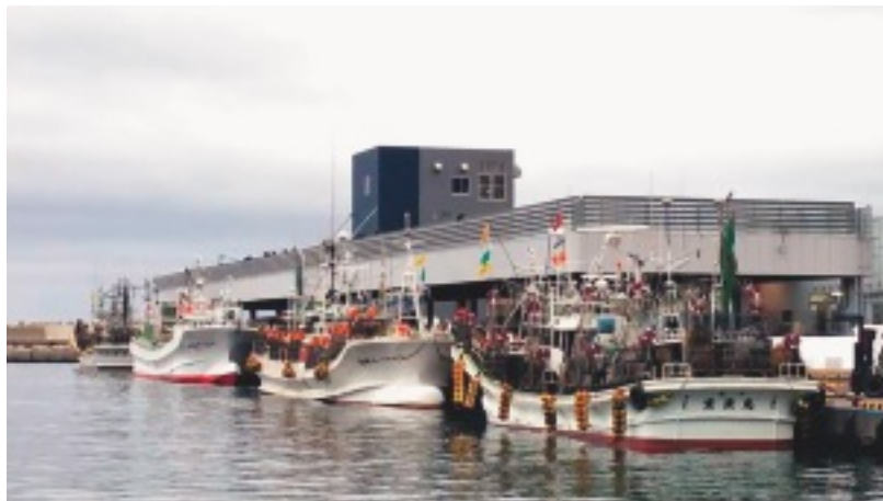
−4.0 m 岸壁 係留状況
