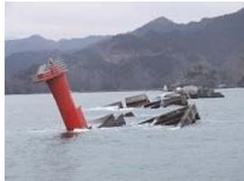
東日本大震災の津波により倒壊した防波堤の事例
