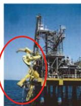
東日本大震災時に船舶が離脱できずに破損したローディングアーム
