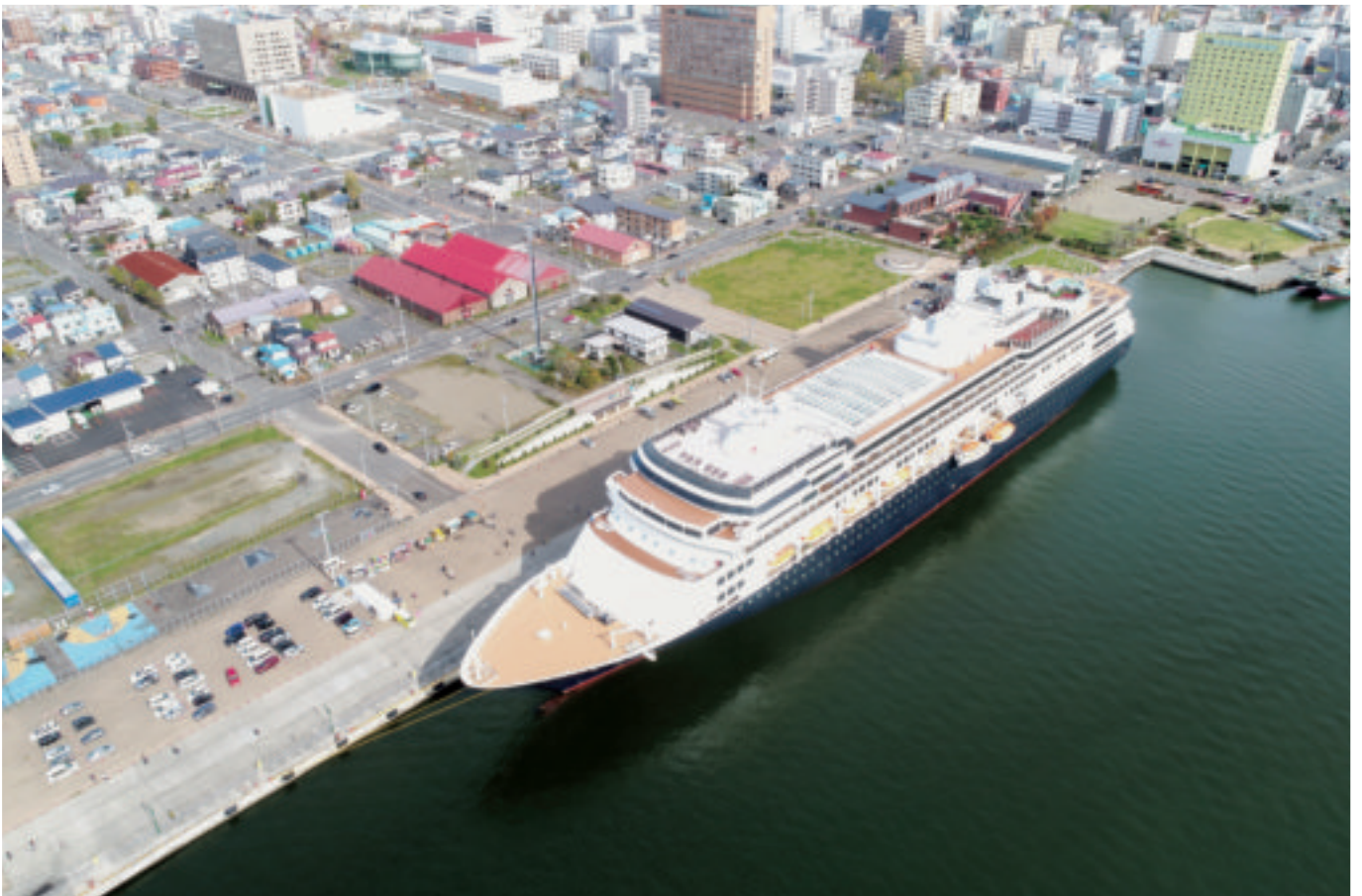
構成施設 (耐震・旅客船ターミナルと幸町緑地)
