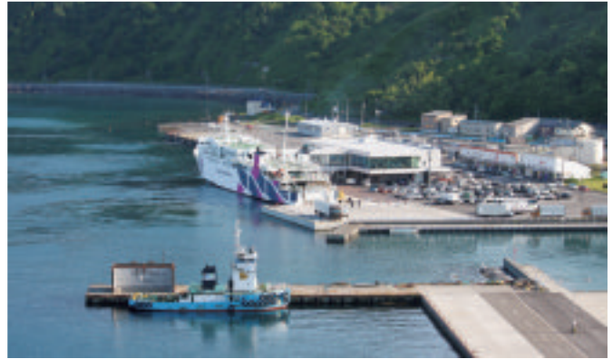
鴛泊港フェリーターミナル (H26.6.24)
