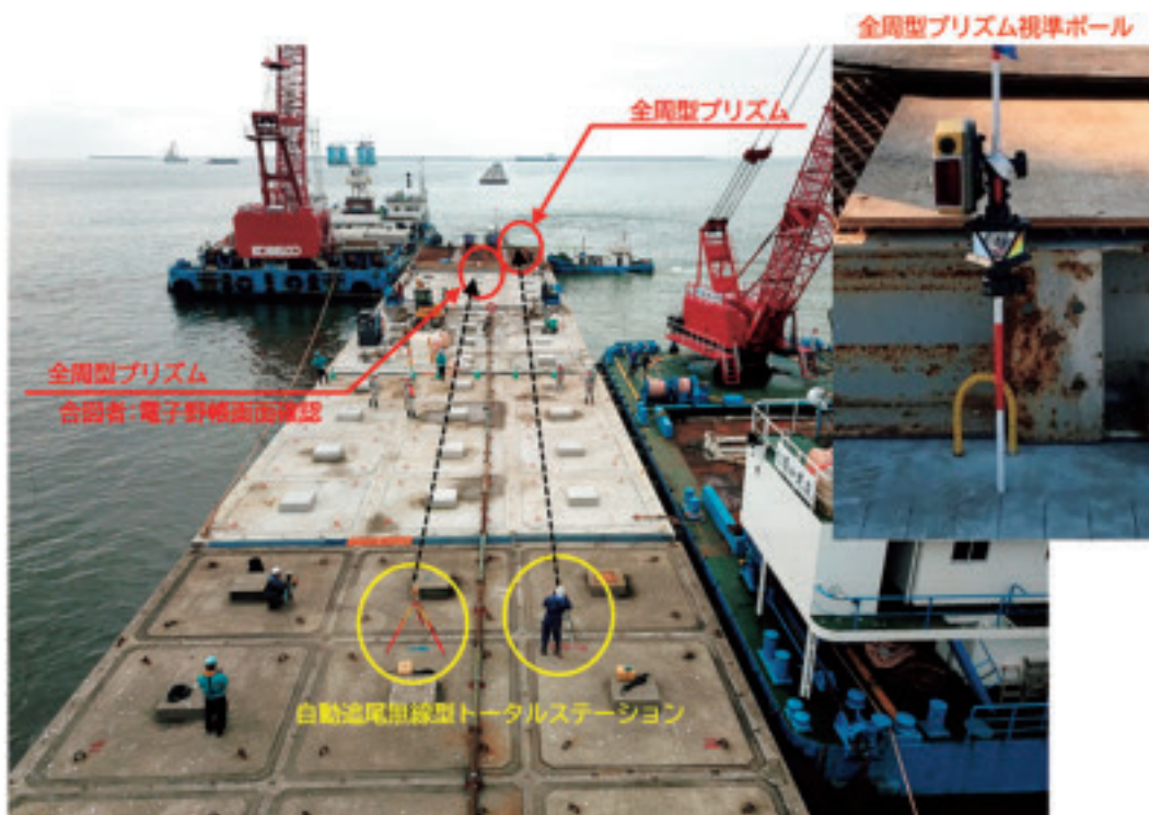
自動追尾無線型トータルステーションによる据付ケーソン誘導
